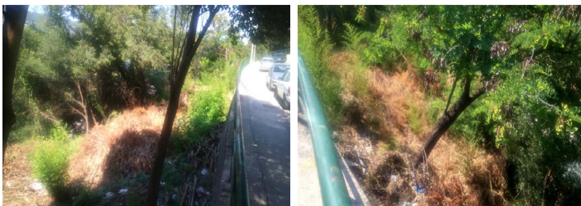
Sl. 2.10-2.11. Pogled na lokaciju sa ulice Orjenski bataljon
