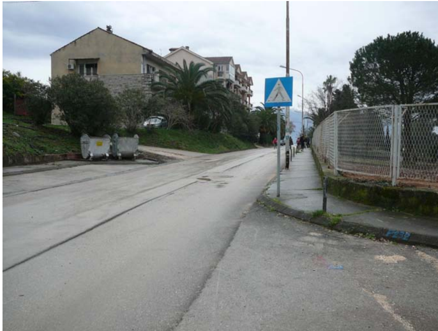
Slika 8. Lokalni put na koji će biti priključena lokacija projekta
