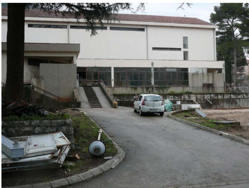
Slika 2. Objekat u okviru lokacije projekta koji će se koristiti za smještaj radnika
