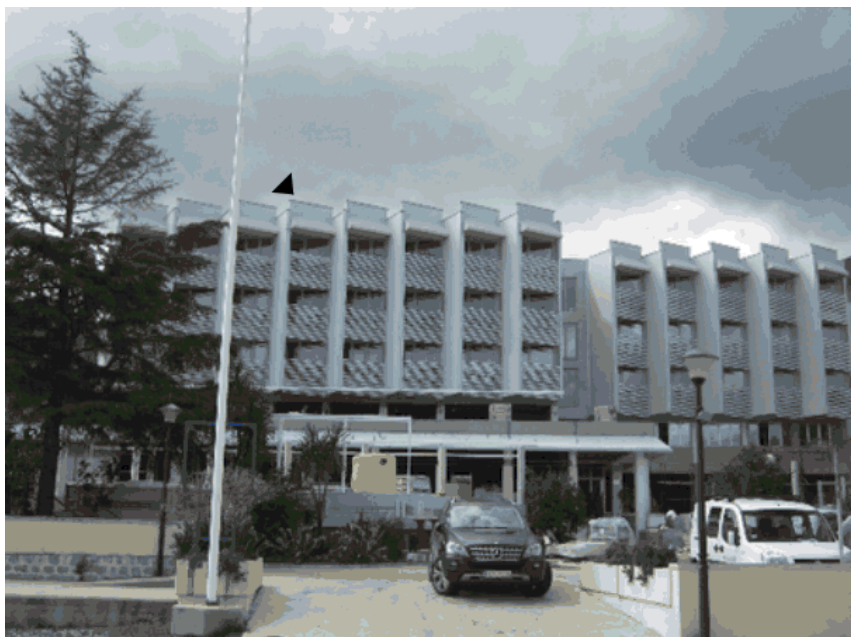
Slika 1. Izgled lokacije „HN08 Hotel Delfin“
