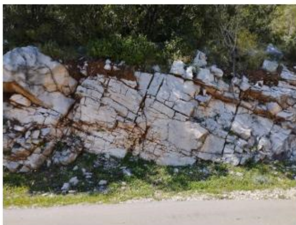
Slika 7: Slojeviti do bankoviti ispucali krečnjaci eocenske starosti, lokalno prekriveni tankim deluvijalno-eluvijalnim pokrivačem, u površinskoj zoni jače ispucali, vidljivi u zasjecima uz postojeći put od Sutorinskog polja ka grebenu
