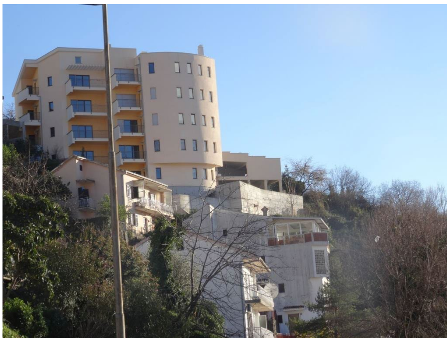
Slika 2.3. Izgled okoline betonskog zida na kojem će se postaviti bazna stanica
