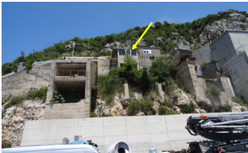
Slika 4.2. Objekat na kome je planirana instalacija opreme u odnosu na okolinu
