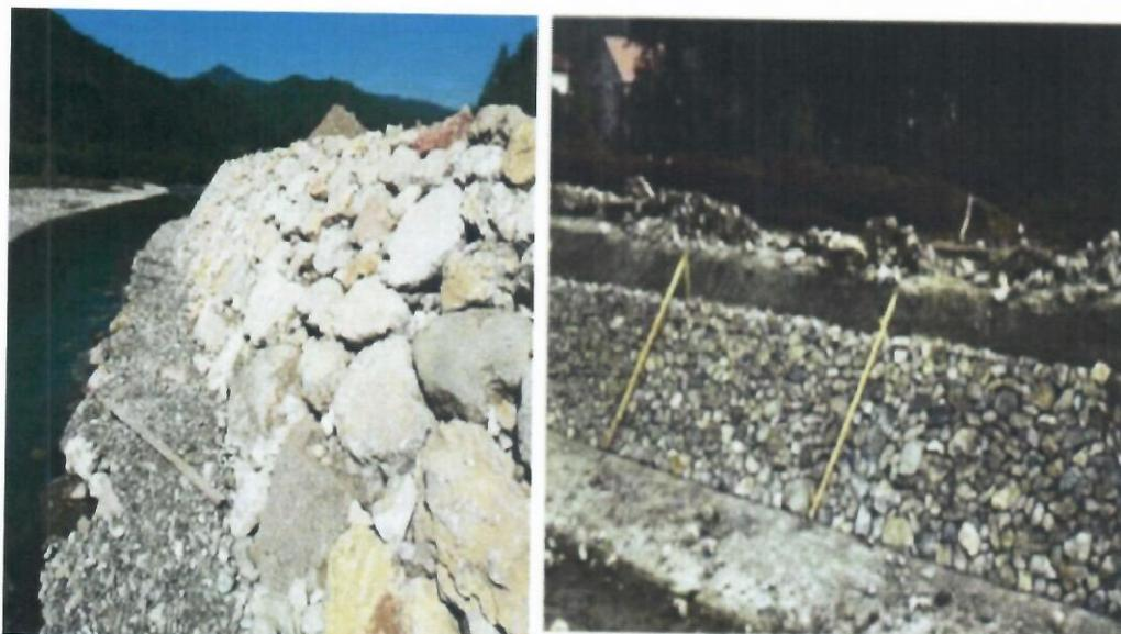
Slika 3.2. Primjer regulisanog korita lomljenim kamenom
