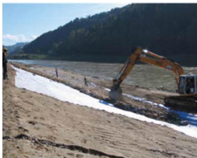
Slika 3.3. Primjer ugradnje geotekstila
