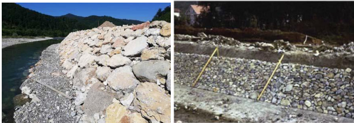
Slika 3.2. Primjer regulisanog korita lomljenim kamenom
