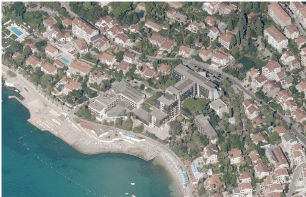
Slika 2.2. Izgled lokacije i okruženja na kojem je planirana bazna stanica
