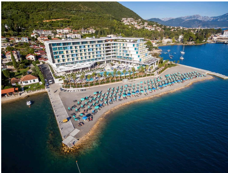
Slika 2.2. Izgled lokacije i okruženja na kojem je planirana bazna stanica
