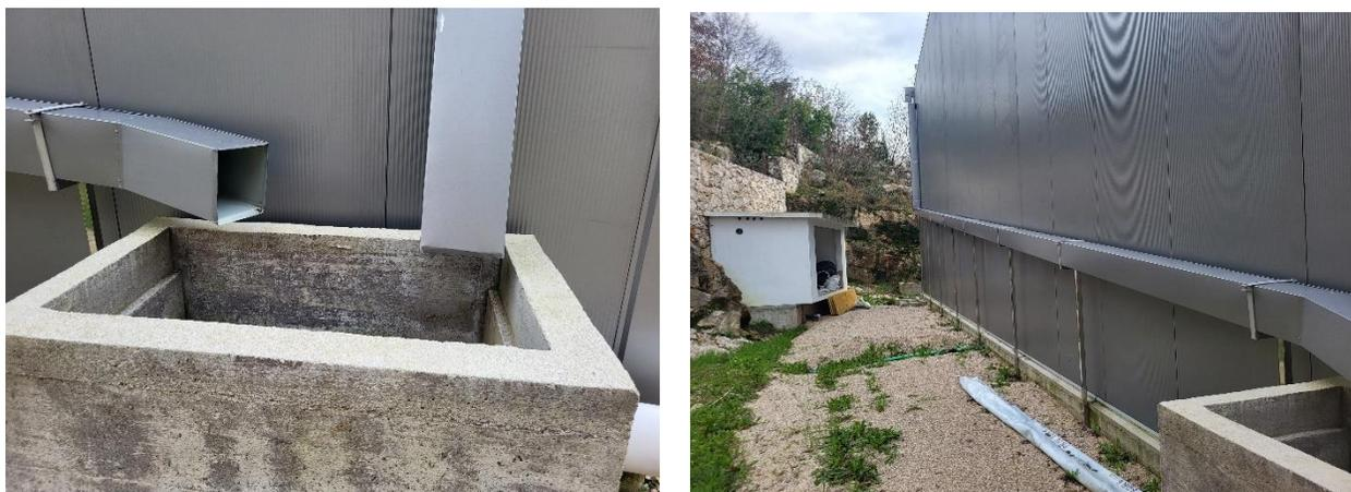
*Slika 5.4. i 5.5. Sistem vanjskih oluka za kanalizacije pale i otekle atmosfere vode*
