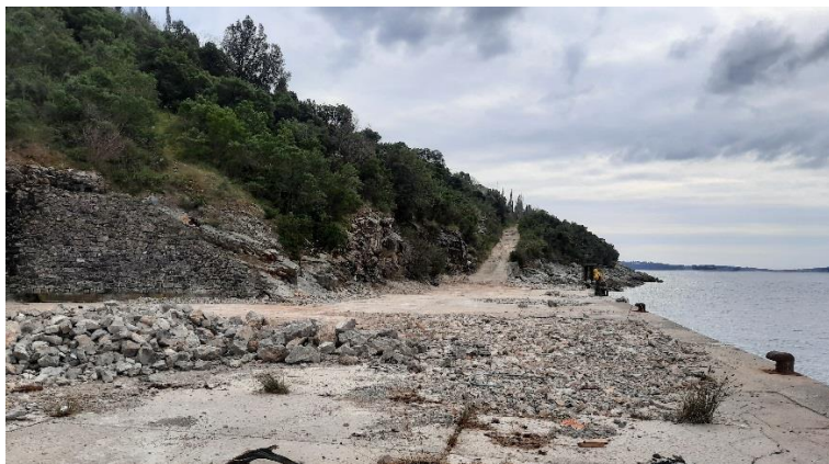
Sl. 4.1. Ambijentalne karakteristike šireg zahvata, staro vojno pristanište, vegetacija makije, pješačka pristupna staza, koja po DSL sektor 32 treba da postane šetnica, i da vodi do buduće plaže
