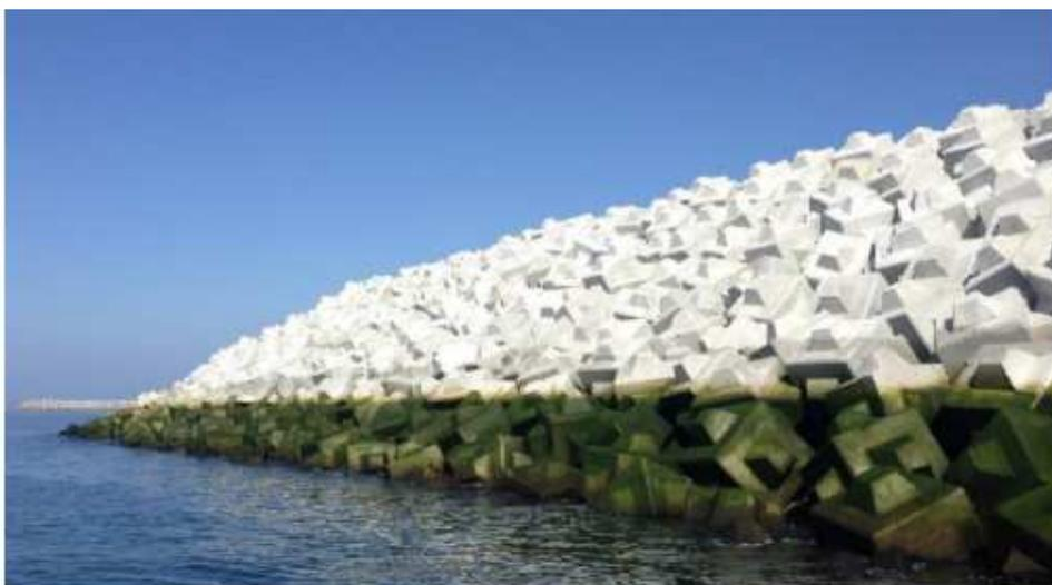
**Slika 3.3.13.** Pokos trupa lukobrana s Cubipod primarnom zaštitom
